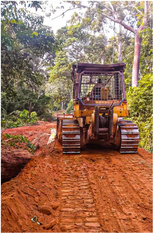
Réhabilitation en cours de la route Bolo Djembe
